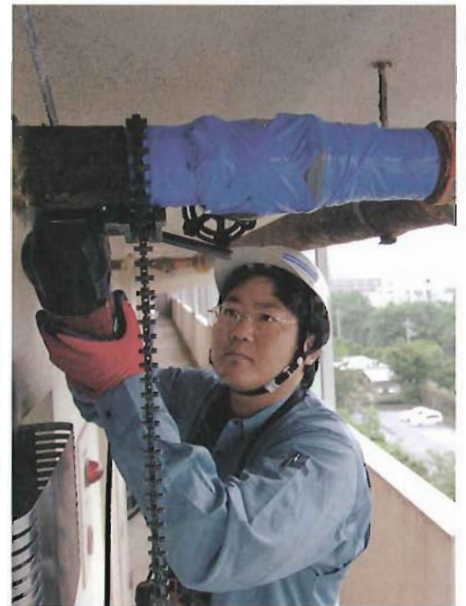
チェーンソーで、水漏れを起こしている箇所をカット、手際よく新しい配管と取り替える。チーム全員が手分けしながらムダのない作業がすすめられています。これぞまさしくプロの仕事。
